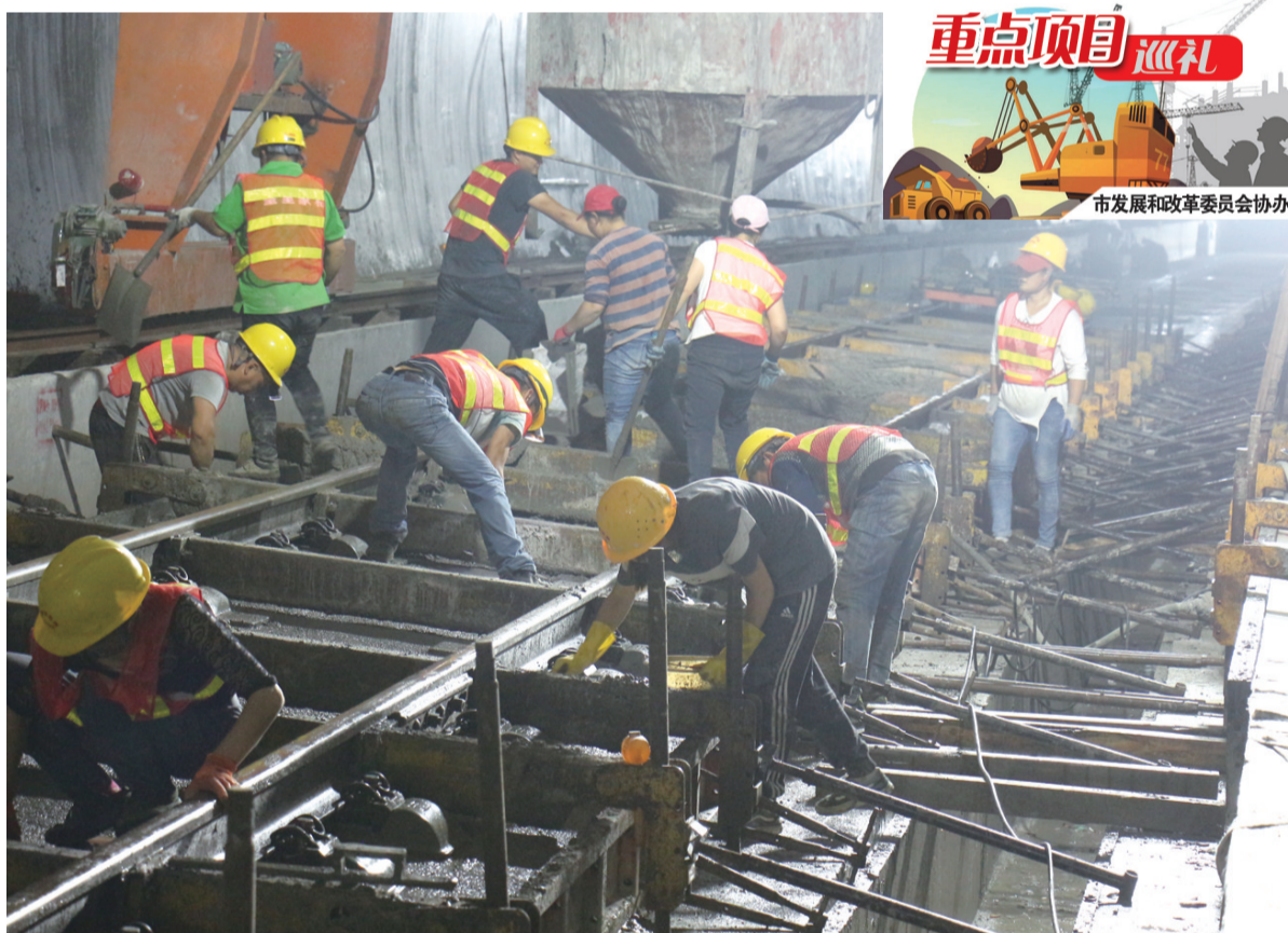
张吉怀铁路隧道、桥梁、路基、无砟轨道等工序全面开工。图为中铁四局一公司张吉怀铁路一分部的建设者昼夜分班组，科学组织施工。
