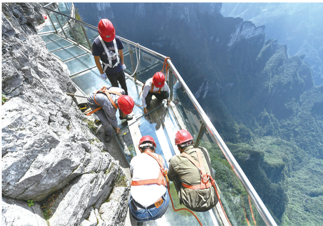
9月7日，天门山景区对西线玻璃栈道进行更换玻璃施工，此次更换的玻璃栈道总长度为60米，使用抗弯能力强、耐冲击强度高的厚度30毫米的夹胶钢化玻璃，以确保安全性。图为施工人员对西线玻璃栈道进行更换玻璃施工。本报记者 邵颖 通讯员 丁云娟 摄
