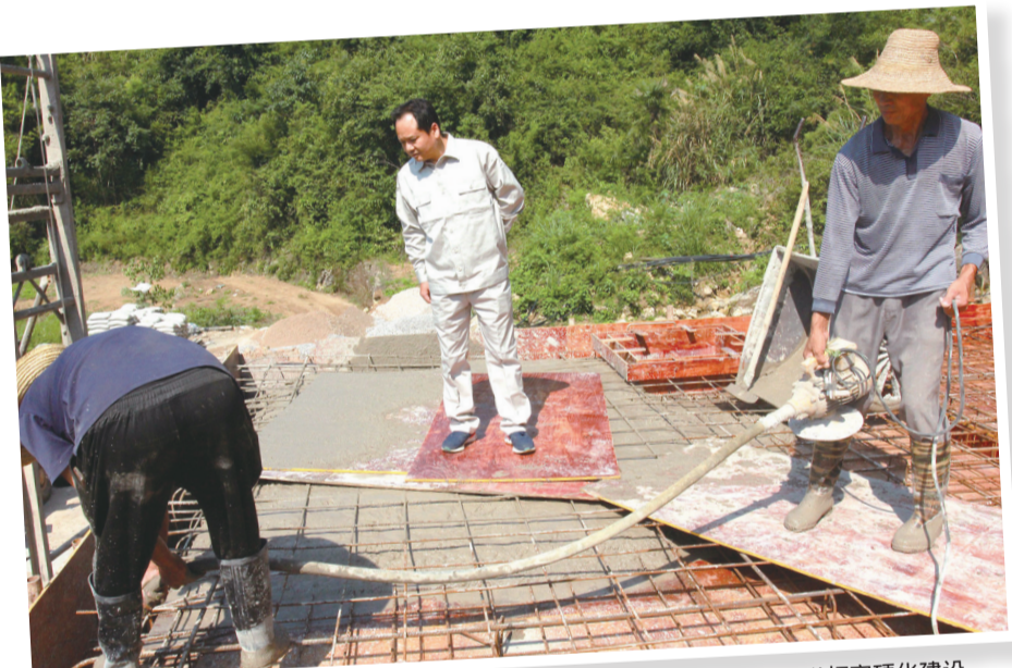
熊文虎（中）在查看村主干道路拓宽硬化建设。
