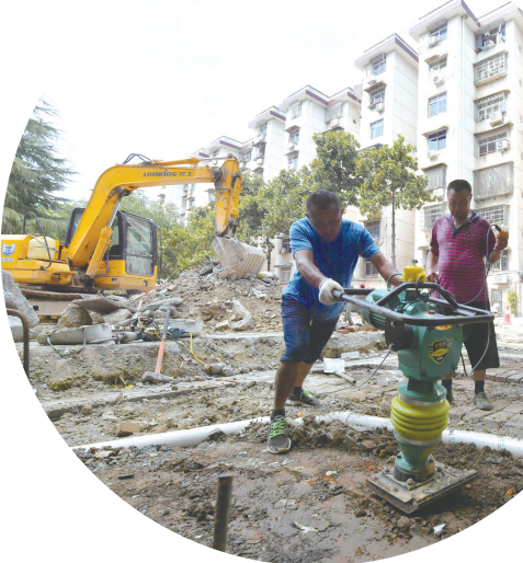
工人正在进行门卫室垫层施工
