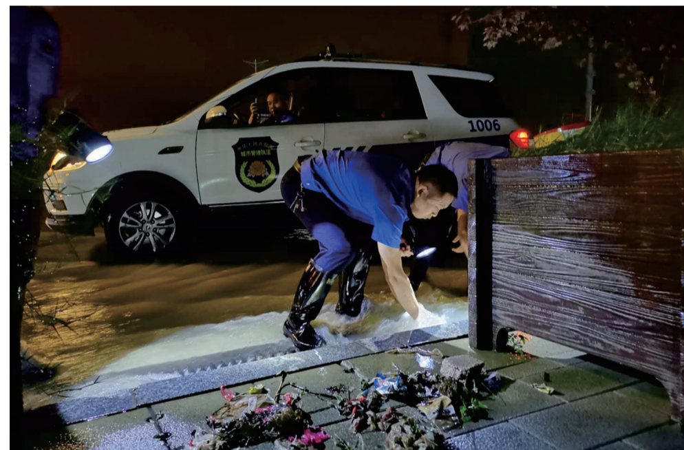
区城管局党组副书记、副局长汤国斌带领城管工作人员在巡察时疏通下水道井盖。
