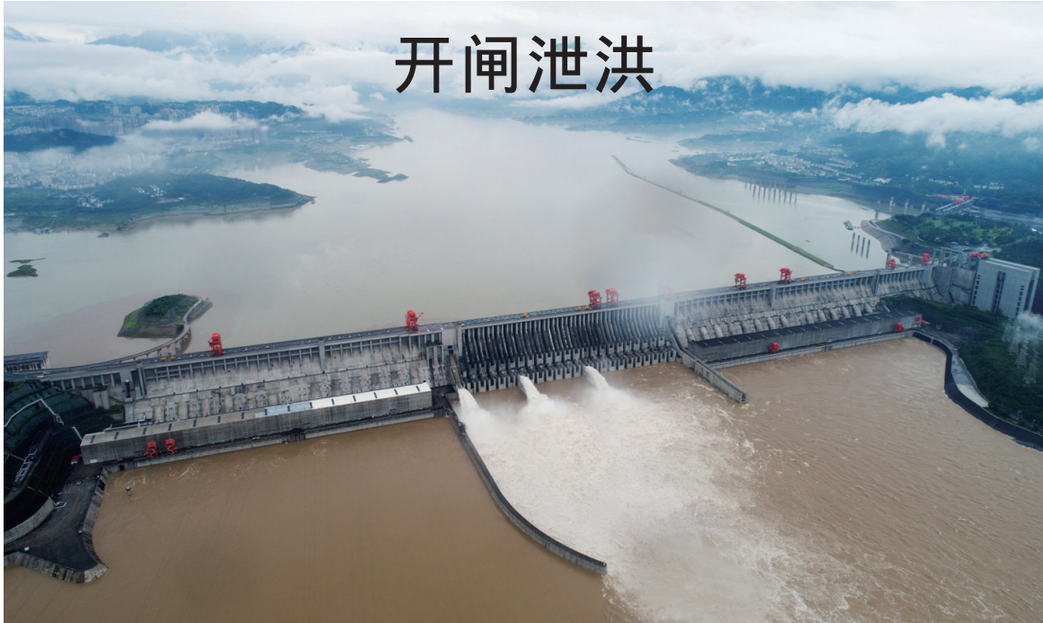
长江2020年第1号洪水 在长江上游形成 长江三峡枢纽开启泄洪深孔泄洪（7月2日摄，无人机照片）。 新华社发（王翌摄）
