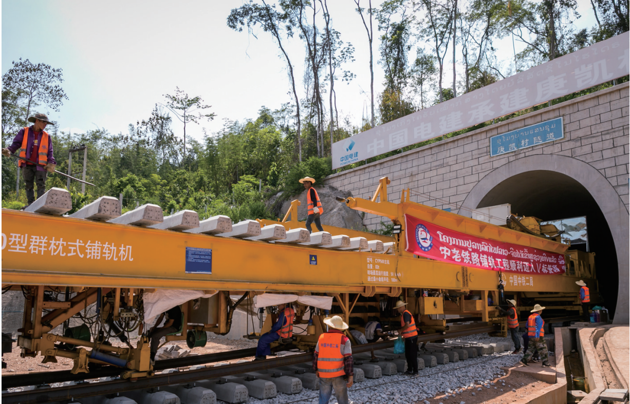
5月23日，在老挝万象省庚凯村隧道的中老铁路施工现场，中老两国工人协力铺轨。 随着每排14根轨枕按照规定距离平稳铺过庚凯村隧道，500米长钢轨随着牵引机稳稳落定，中老铁路铺轨23日通过第一座隧道，从老挝首都万象一路向北。
