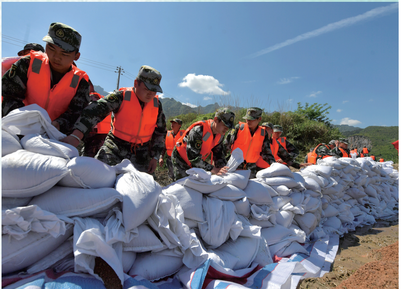
加固抢险分队紧张有序加固河堤。本报记者 庾兴亮 摄
