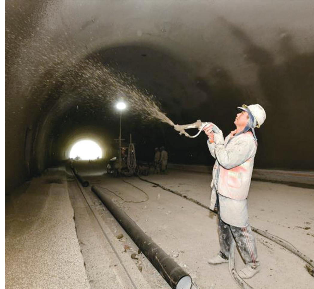
4月28日，武陵源区S248插分公路杨枝界隧道内，工人们正在抓紧开展隧道防火涂料喷涂、灯具放置等项目施工。据介绍，插分公路建设工地目前已有多名工人到岗复工，正抢抓工程进度。插分公路既是全市旅游交通重点工程，又是武陵源区和永定区富民强区的民生工程，建成通行后将成为武陵源核心景区又一条旅游快车道。
