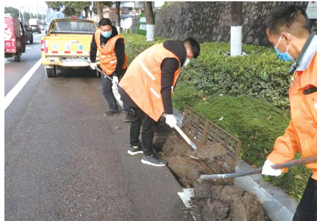
近期，市市政设施维护服务中心对市城区市政设施进行了全面检查维护，对排水管渠进行了清淤疏通。
