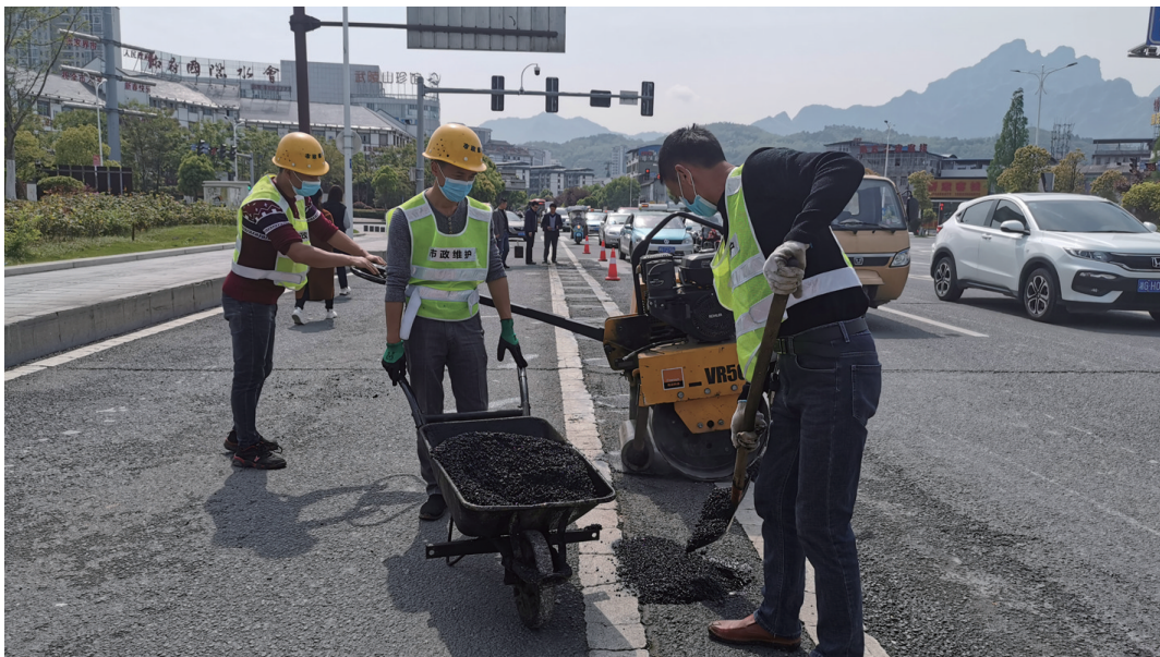
4月9日，市城管局市政设施维护管理处对拆除后的仙人溪桥隔离墩路面进行修补。 本报记者 唐生英 通讯员 曾兰淑 摄
