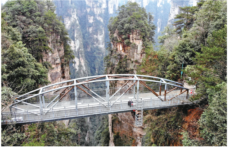
3月4日，袁家界钢架桥维修施工 航拍 龚素禾
