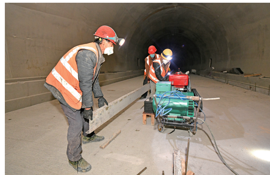
▲武陵源区插分公路杨枝界隧道工地，工人正在进行隧道路面铺设施工。市级重点工程 S248插分公路杨枝界隧道全长2010米，是进入武陵源的交通大动脉。公路全线施工完成后，将有力带动武陵源区乡村旅游和农业产业发展。 本报记者 鄢渊 通讯员 蒋兰 摄
