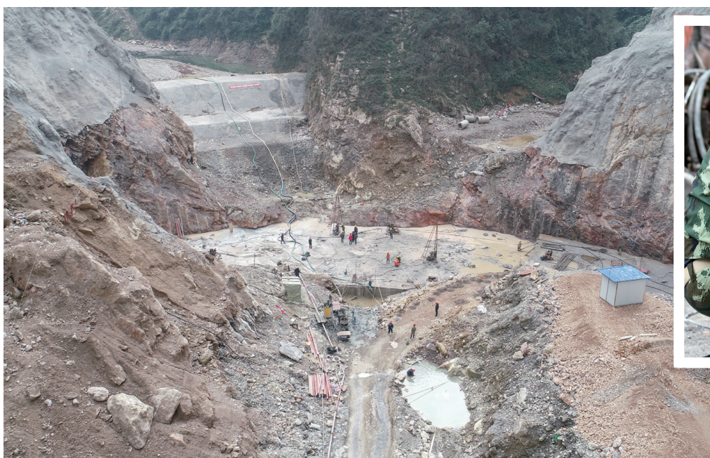
▲▲牛洞口水库工程位于桑植县桥自弯镇牛洞口村境内，是一座以供水、灌溉为主，兼顾防洪、生态用水等综合性小型水利枢纽工程。该工程是由大坝、灌区两大部分组成，水库总库容为771.4万立方米，属于小（I）型水库，总工期为36个月。
