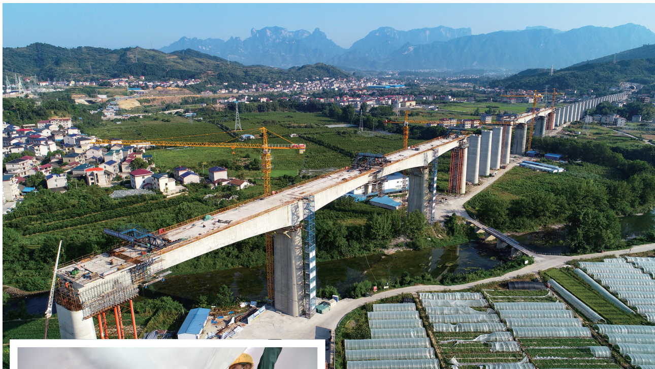
▲▲张吉怀铁路(张家界经吉首至怀化)，北起张家界市，经湘西土家族苗族自治州，南接怀化市，线路全长247.481km，设计时速350km/h。
