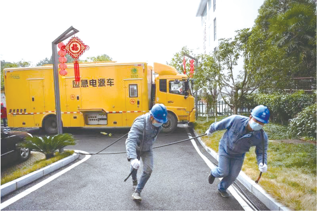
2月3日，为保障市新型冠状病毒感染的肺炎疫情防控工作指挥部高效、不间断运转，国网张家界供电分公司工作人员对指挥部所在地架设备用电力设备。 张明清 摄
