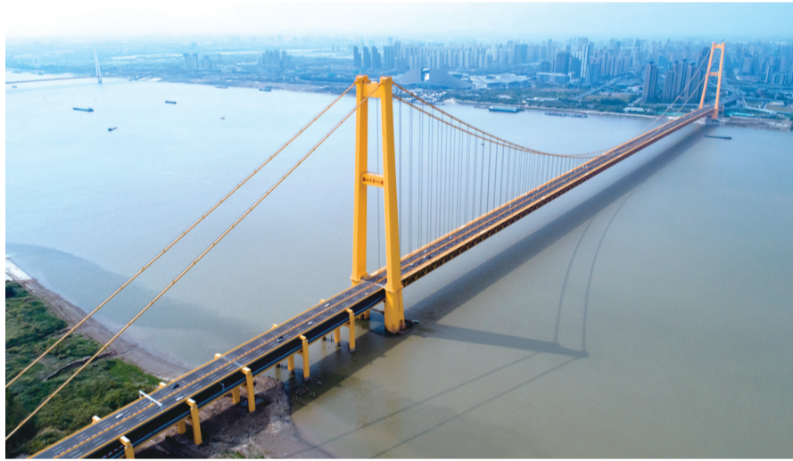
10月8日,武汉杨泗港长江大桥正式通车(无人机拍摄)。当日,长江上首座双层公路大桥武汉杨泗港长江大桥正式投入使用。杨泗港长江大桥全长4.13公里,主跨1700米,一跨过长江。大桥上层为城市快速路,双向6车道,设计行车时速80公里;下层为城市主干道,双向6车道,设计行车时速60公里。新华社记者 熊琦 摄
