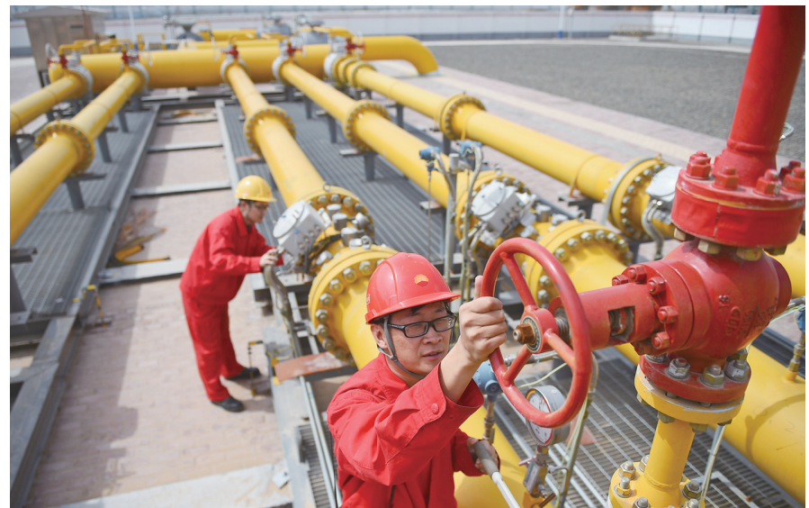
▲中石油西气东输管道公司银川管理处的巡检人员西气东输中卫气阀站内的管道、压力表进行检查（2016 年 3 月 28 日摄）。 新华社记者 王鹏 摄
