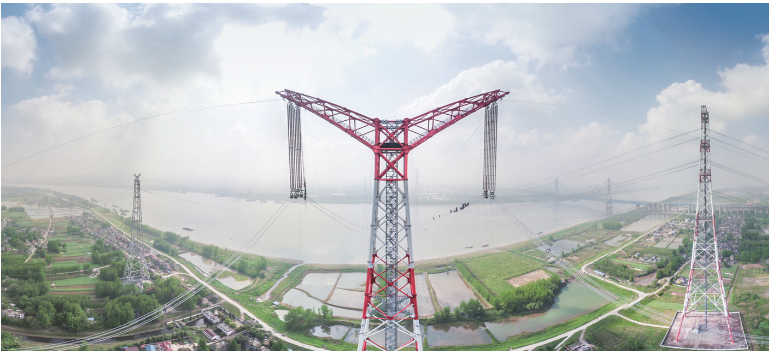
▲随着西电东送 1100 千伏 新疆准东 安徽皖南 特高压直流工程的最后一相导线顺利跨越天堑长江，世界电压等级最高的特高压大跨越 昌吉特高压长江大跨越工程全线贯通。这是导线展放后的昌吉特高压长江大跨越工程北岸跨越塔（2018 年 4 月 15 日无人机拍摄）。 新华社记者 郭晨 摄
