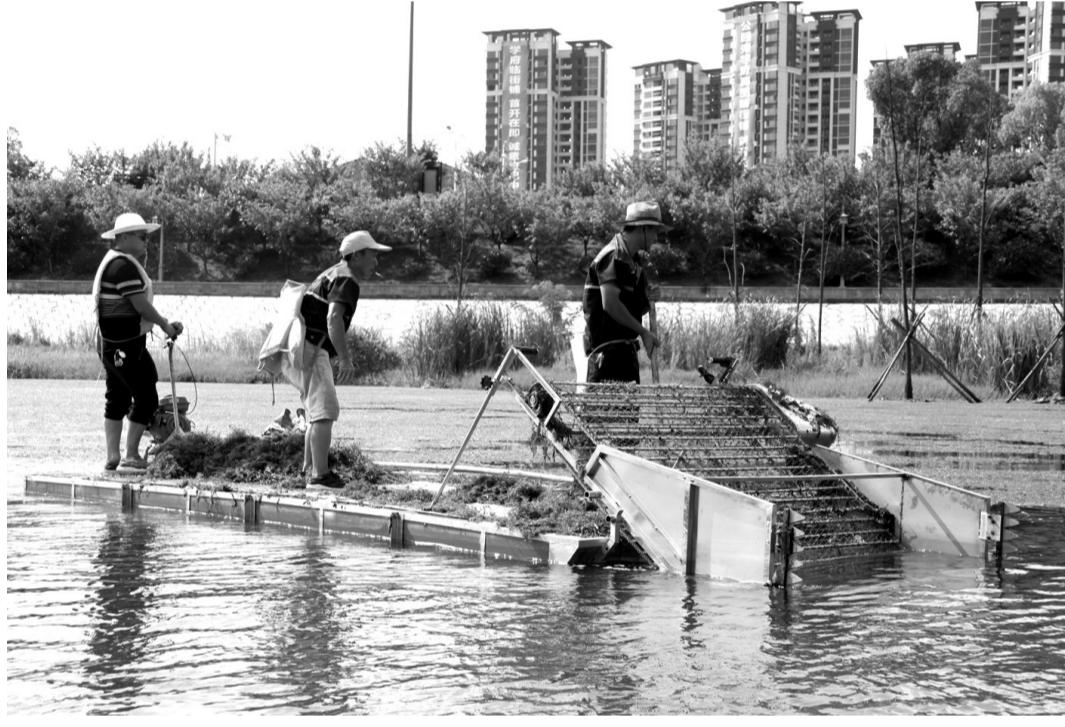
8月5日，市环卫处新添置了两台三刀滚筒式割草机，大大降低了环卫工人的劳动强度，提高了水草打捞的工作效率。
