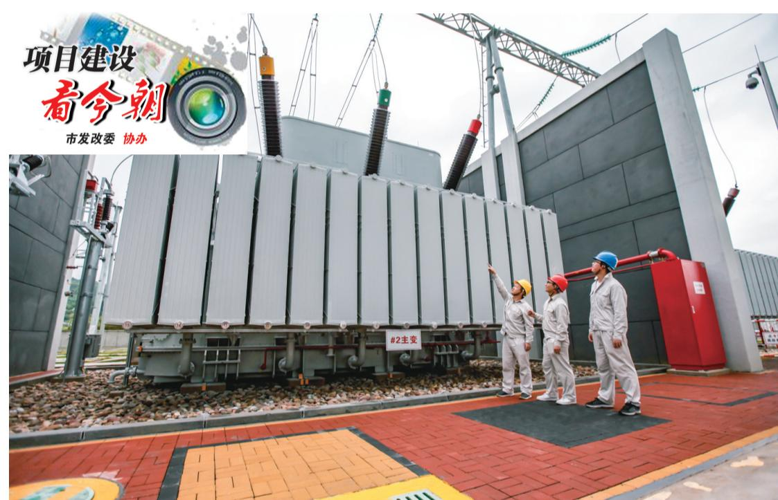
8月7日，国网张家界供电公司220千伏立功桥变电站2号主变扩建工程提前2个月投产送电，新增变电容量18万千伏安。
