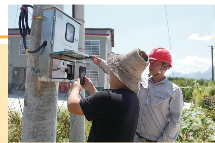
在永定区大庸桥街道大溶溪村,为配合农田抗旱抽水,立功桥供电所为农户安装了扫码用电装置。农户只需打开支付宝或电E宝,扫描粘贴在表箱上面的二维码,即可快速取电用电,用电结束后,系统会自动结算,自动扣除电费。该项装置的推广,可有效减少私拉乱接、挂钩抽水行为,有利于农田灌溉用电安全,还能防止企业效益流失。
