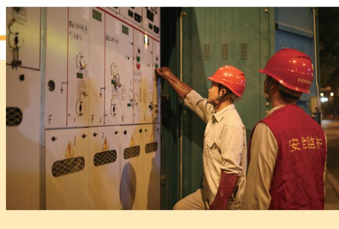
午夜零点,为了配合35千伏二家河变电站转出部分负荷,永定区供电公司配网高压班人员正在月亮湾1号环网柜现场进行倒闸操作,将重载线路的部分负荷转移到其他互联线路,以减轻重载线路的压力。倒闸操作将会有5至10分钟的短时停电,所以选择在午夜零点之后进行,避免短时停电给客户带来影响。
