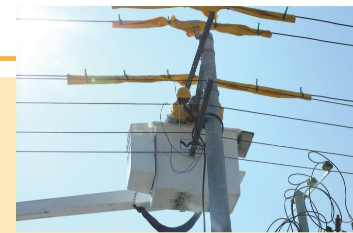
在老沙线沙朝支线带电作业现场,国网张家界供电公司带电作业中心人员头顶烈日,冒着室外37摄氏度的高温,为辖区用户正阳文化旅游发展有限公司带电接入变压器。通过带电作业,可以避免对线路进行停电操作,提高供电可靠性,保障用户不间断供电。
