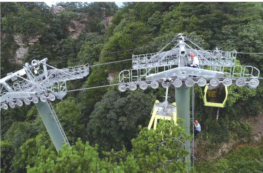
7月10日,杨家界索道工作人员在对索道缆绳、轮组等设备进行安全检查。进入七月份以来,武陵源风景区迎来暑期旅游接待高峰,当地景区管理部门增加了对索道、户外电梯、观光车等特种接待设施的巡检次数,并针对性地设立专人巡检和特殊情况下的专工巡检,进一步完善高温天气应急处置措施,全力保障暑期游览安全。
