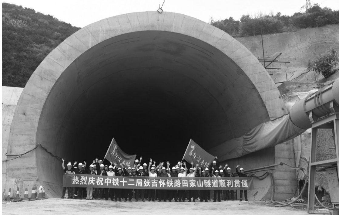
6月25日,位于永定区枫香岗街道办事处后坪社区境内的张吉怀铁路三标一分部田家山隧道顺利贯通,据悉,该隧道为单洞高铁隧道,单洞长度共计605米,隧道洞内净宽15.76米,净高8.78米。(通讯员 叶秀月 廖朝辉)
