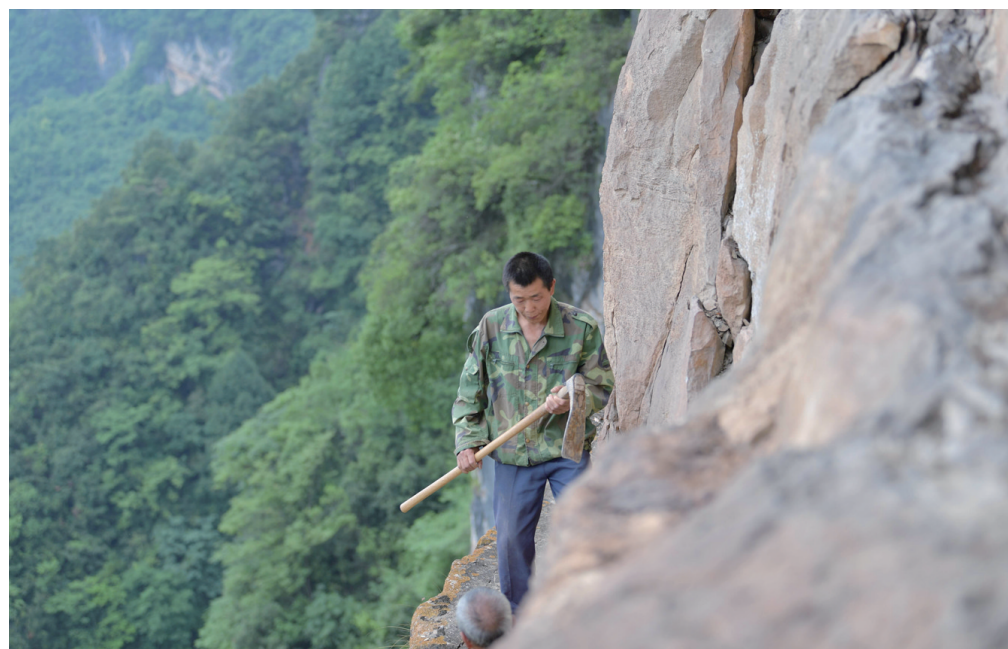
6月10日,陈显兵在悬崖上清理石头。 地处大山深处的湖北省恩施土家族苗族自治州巴东县支坪镇尚家村,壁立千仞,风光壮美。为改变贫困落后的面貌,今年51岁的村民陈显兵从2017年开始,在村里的支持下,带领群众开始在“天天眼”绝壁上修路,目前已修出了一条几公里长的简易观光山路。乡亲们希望这里的绝壁美景能够被开发,通过发展旅游,带动村民致富。 新华社发(杨顺杰摄)
