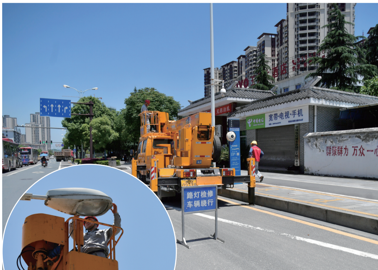
5月22日，张家界路灯管理所深入大街小巷检修路灯，全力做好照明设施维护管理，积极配合我市创建全国卫生城市的验收。 ↑图为工作人员准备对故障问题路灯检修。 ↓图为工作人员维修检查路灯。 本报记者 唐兴亮 通讯员 陈俊元 摄
