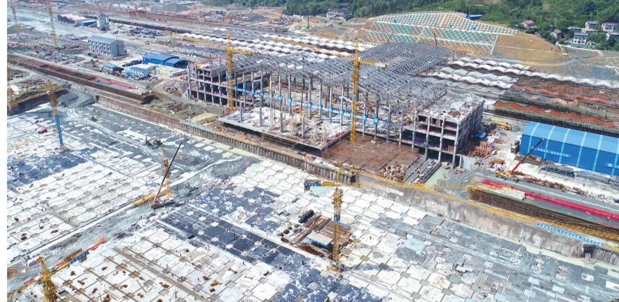
正在建设中的张家界高铁西站。
