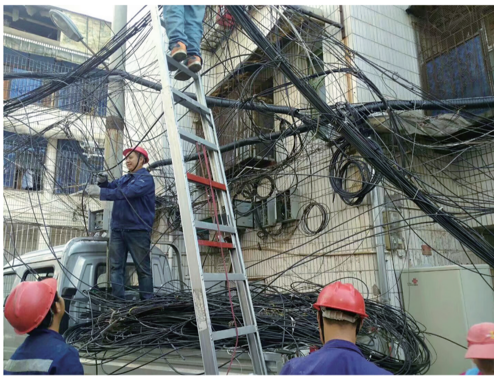
工人们正在剪掉陈旧、多余的各种通讯网线路
