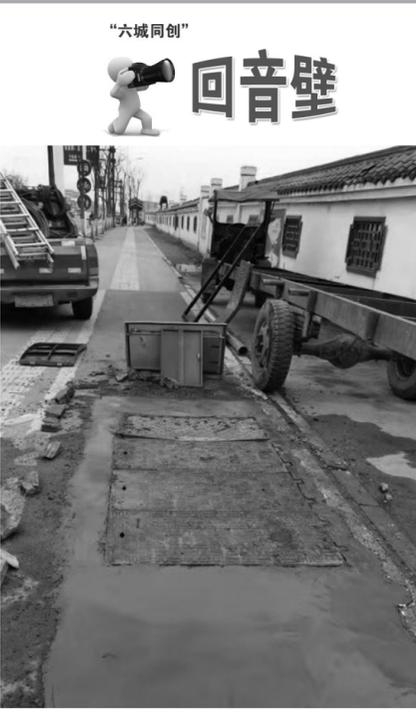
永定区西溪坪贸易路区商粮局旁边破损的电力井盖已修复。
