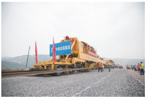
长铺机开始第一对500米长钢轨铺设
