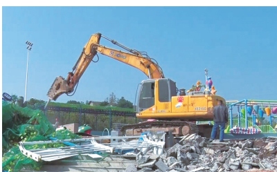
永定区国土资源执法人员对张家界中兴园林绿化公司（中兴水上乐园）非法占地建筑物进行拆除
