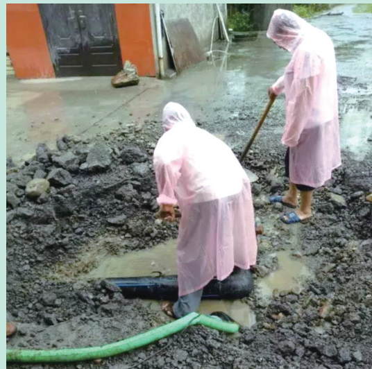
供水站工作人员冒雨抢修损坏水管。
