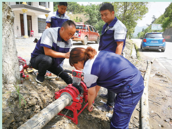
供水站工作人员抢修损坏水管。易善任 摄
