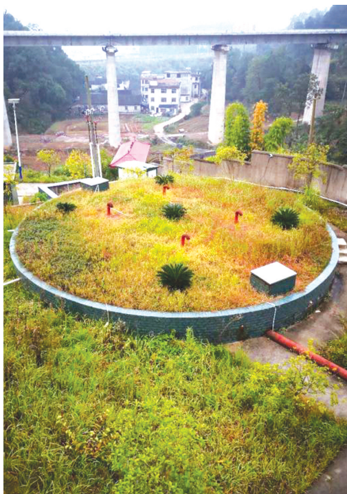
阳湖坪水厂一角
