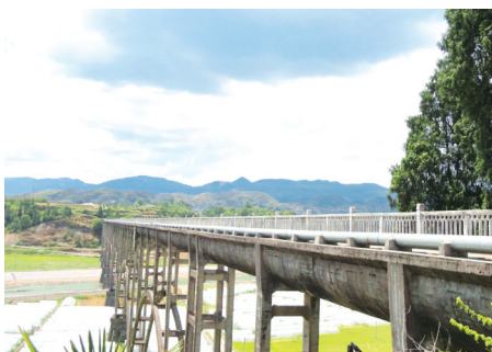
永定区茅溪灌区官坪渡槽
