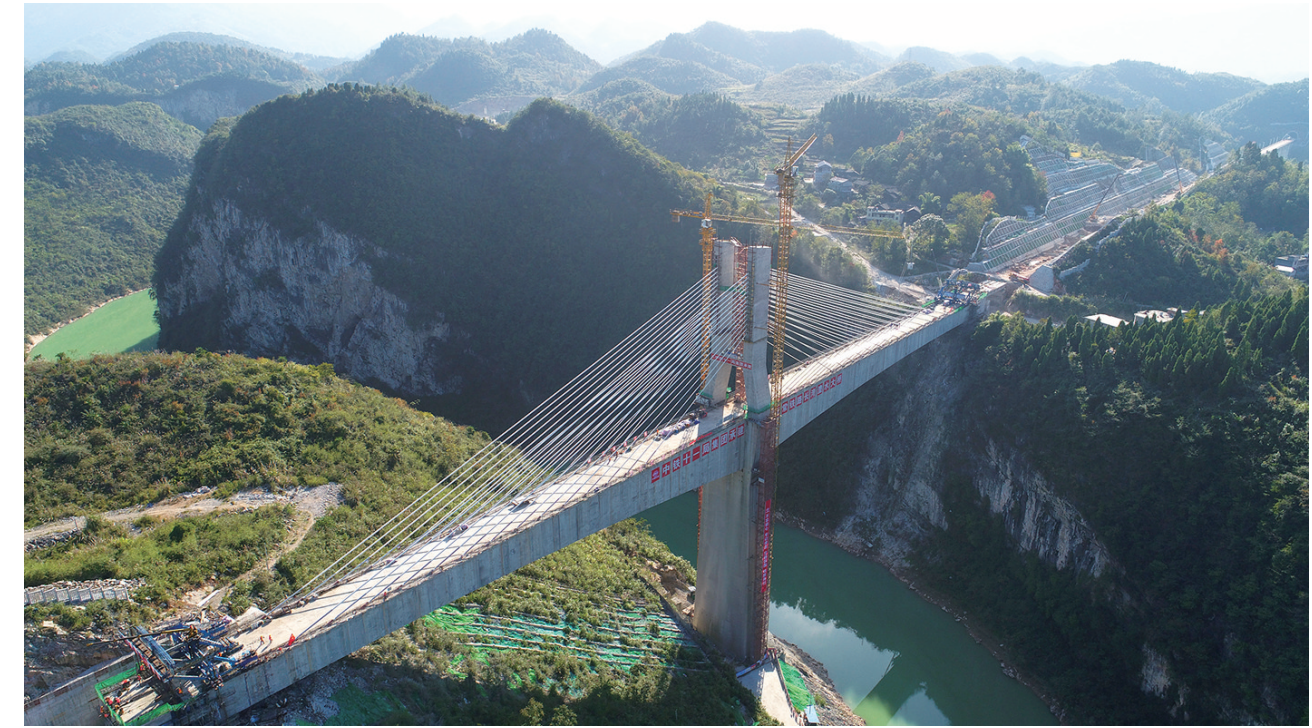
10月29日在桑植县拍摄的黔张常铁路长湾澧水大桥。当日，由中铁十一局五公司承建的黔（江）张（家界）常（德）铁路长湾澧水大桥成功合龙。长湾澧水大桥是黔张常铁路全线重难点控制性工程之一，桥梁全长369.1米，为全线施工难度最大的特殊结构不等跨矮塔斜拉桥。 本报记者 邵颖 摄
