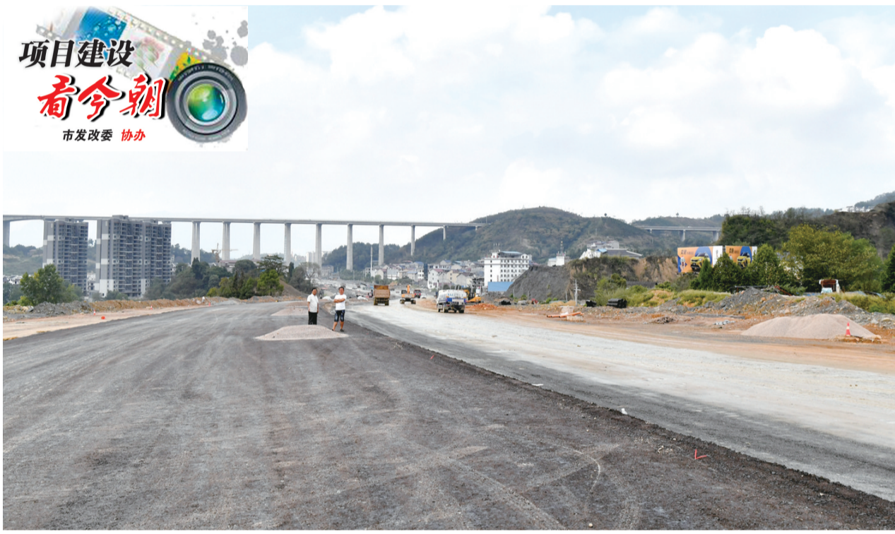
武陵山大道连接市区与武陵源核心区，全长28.4公里。图为正在施工的武陵山大道城区段现场。 本报记者 黄兴亮 摄
