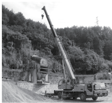
省第七环保督察组正在拆除砂石生产线
