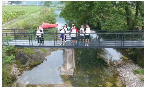
暑假期间，北京科技大学乡桥实践团的大学学生们在了解到慈利县龙潭河镇渠溶村有一座钢索桥因年久失修、村民出行难的实际情况，实践团多方联系，在零阳镇商会的大力资助下，历时一周的时间，8月6日，这座耗资6万多元的新钢架桥建成通行，受到了当地群众的称赞。
